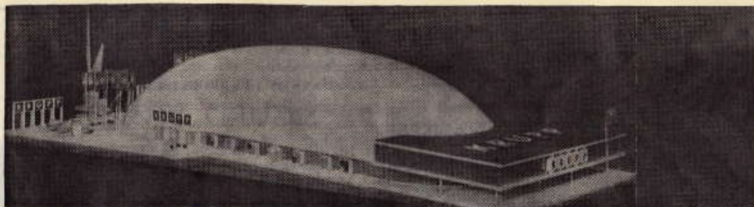
EN ØNSKEDRØM I HAMMERFEST FOR VÅR OPPVOKSENDE IDRETTSUNGDOM. — Haller som holdes oppe av overtrykk, har en størrelse nær opptil en fotballbane.
